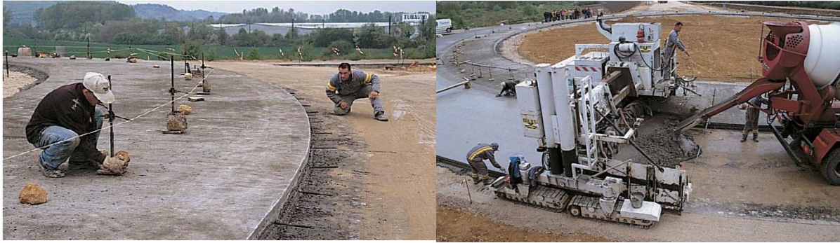
Figure 87. Slipform paving of a large roundabout. Source: Centre d'Information sur le Ciment et ces Applications CTC-T63.
